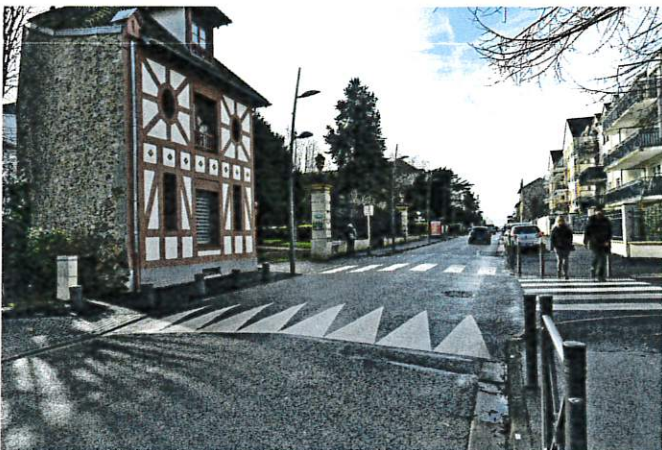
Plateau surélevé réalisé en 2021 Rue de Paris devant la Résidence pour Personnes Agées
